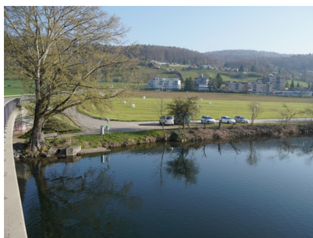
Teilweise kompletter fester Verbau um die Brücke am rechten Ufer; sonst Ufer grob befestigt.
