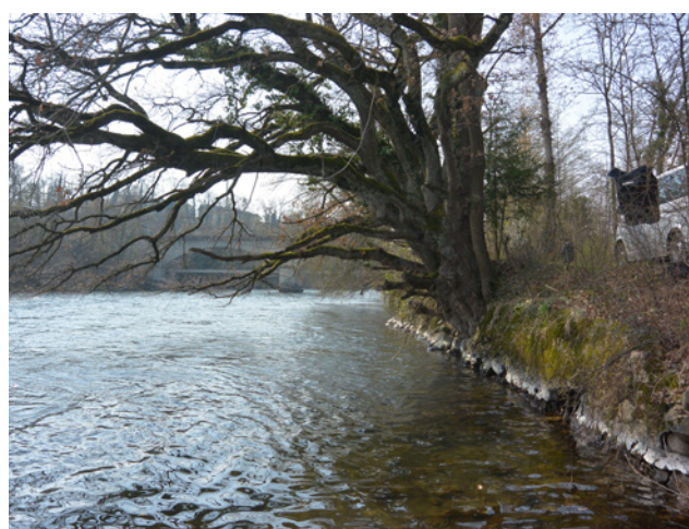
Monotones, befestigtes Ufer direkt unterhalb der Revitalisierung am rechten Ufer.
